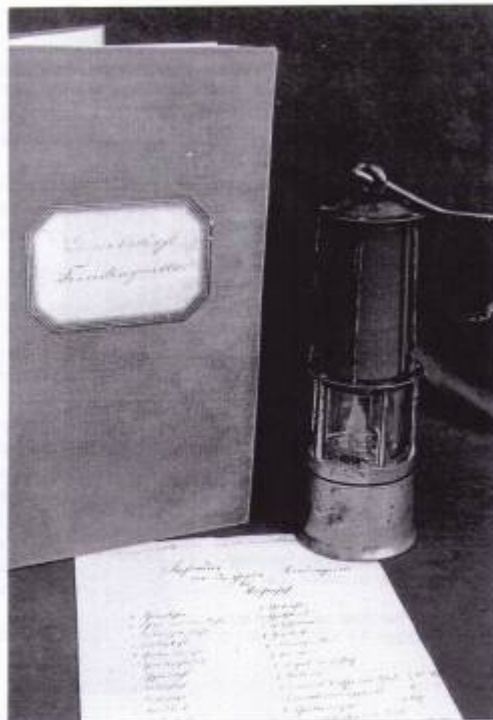
Diese Wetterlampe, Typ 400, FrWo, ohne Verschlusssicherung, gehörte Heinrich Imhäuser aus Wehbach/Sieg. Er war Steiger auf der Kupfergrube „Gewerkschaft Freudenquelle“ in Hüttenseifen bei Wehbach/Sieg. (Foto: Heinz Zander) Quelle: Grubenlampen-Info, 2004, S. 203
