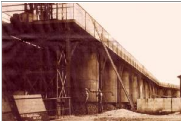
Während die ersten Röstöfen „in den Hang hinein“ gebaut wurden sind spätere Anlagen aus Eisen in direkter Nähe zum Förderschacht errichtet worden. Diese Bild der Röstofenanlage ist von der Grube Bautenberg bei Wilden.
